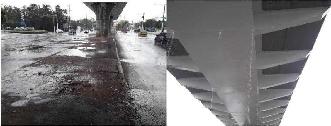
**Fotografía 14: Desagüe de flujo pluvial sobre la vialidad durante un evento de precipitación moderada de las vías del Tren Eléctrico Urbano, en la Av. Ávila Camacho a la altura de Plaza Patria (Captura propia, junio de 2017).**
