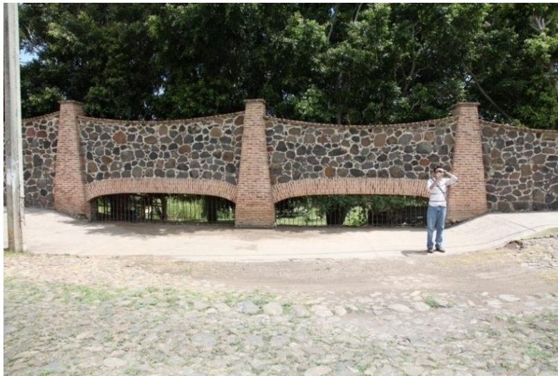
Figura 65. Imagen de algunas viviendas que previamente obturan algunos de los canales más importantes en la antigua carretera Guadalajara-Morelia. Foto Luis Valdivia Ornelas
