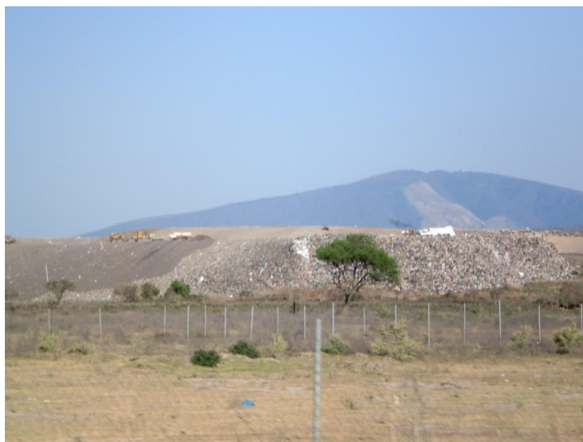
Ilustración 62, Tiradero Municipal, instalación de riesgo
