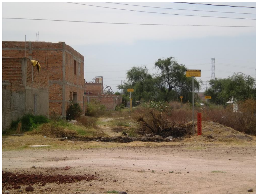
Ilustración 59 Vista de postes de ductos de Pemex
