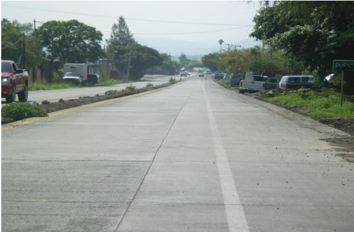
Ilustración 41, Av. 5 de Mayo con rodamiento de concreto hidráulico, en el ingreso al poblado de Puente Grande.
