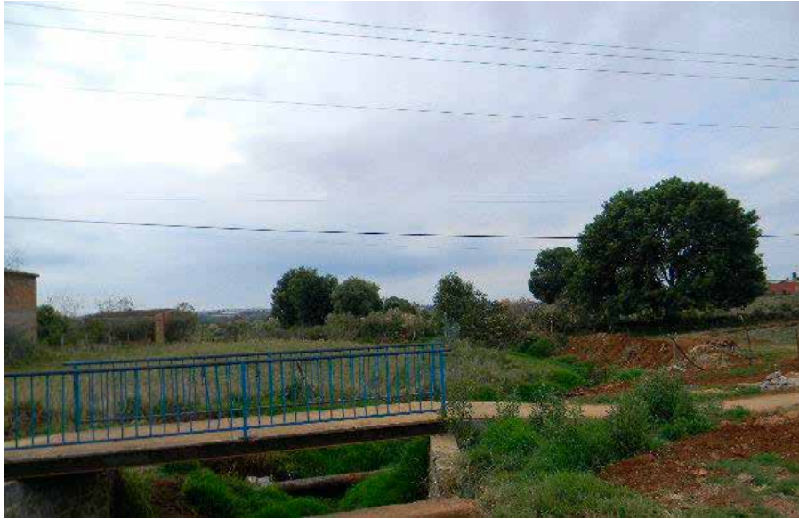
Arroyo el Taray y su cruce con la Av. Hidalgo
