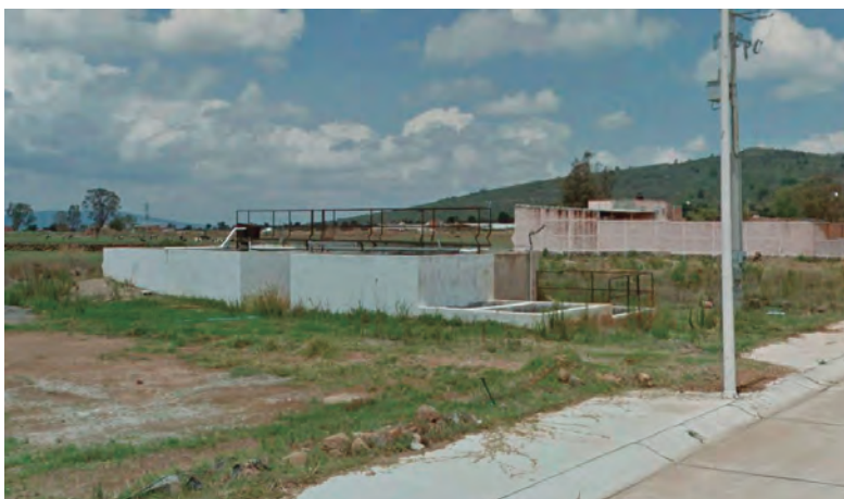
Imagen 9. Planta de tratamiento de aguas residuales para el fraccionamiento Las Fuentes.
