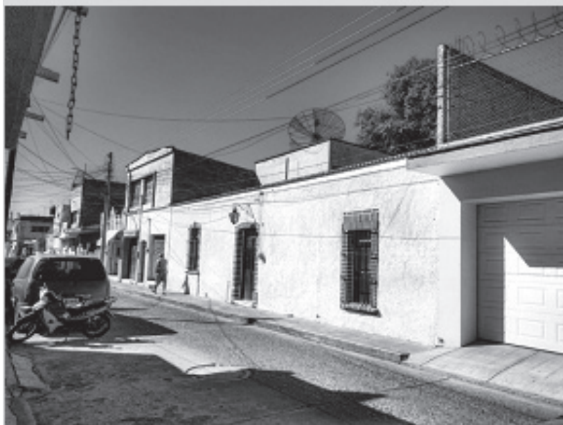
Fotografía 3 Casa de valor patrimonial
