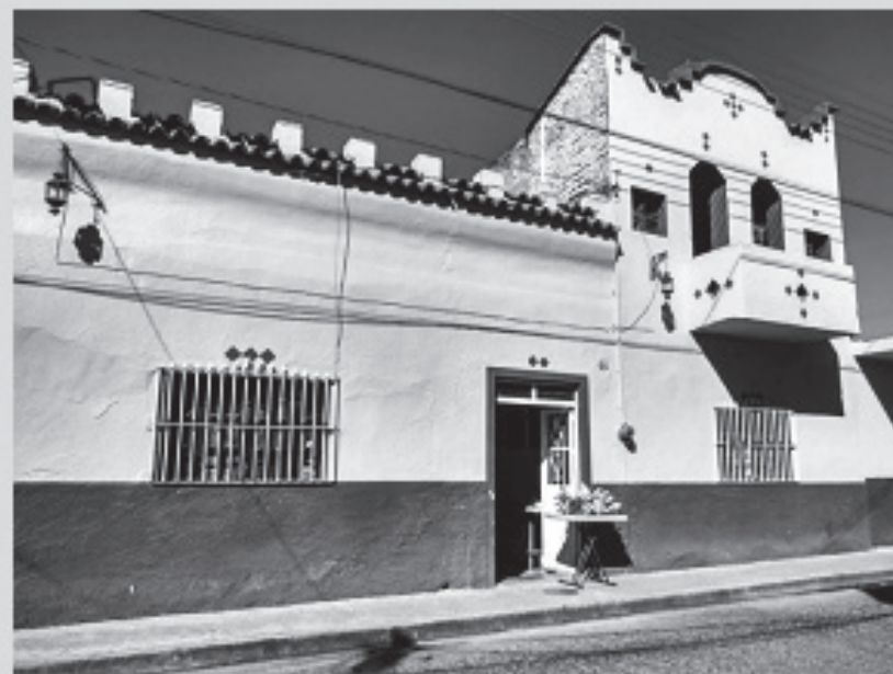
Fotografía 2 Casa con valor patrimonial
