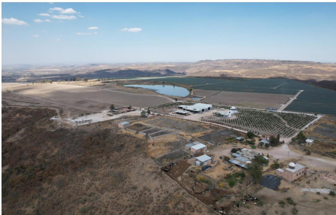
Ilustración 6. Vista aérea del predio
