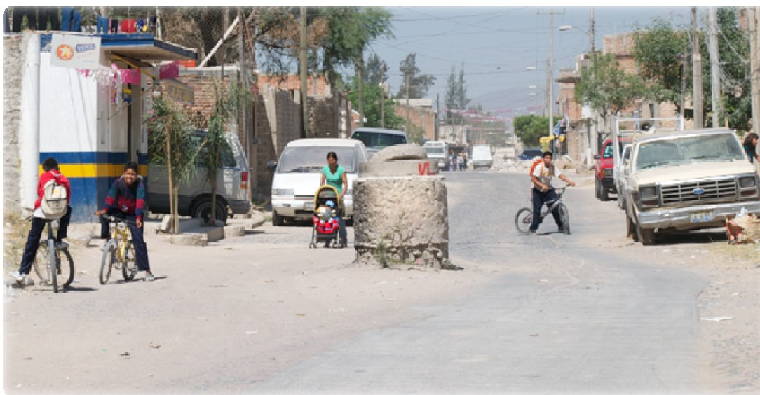
Imagen 17. Alcantarilla de un metro de altura en la colonia La Huizachera
