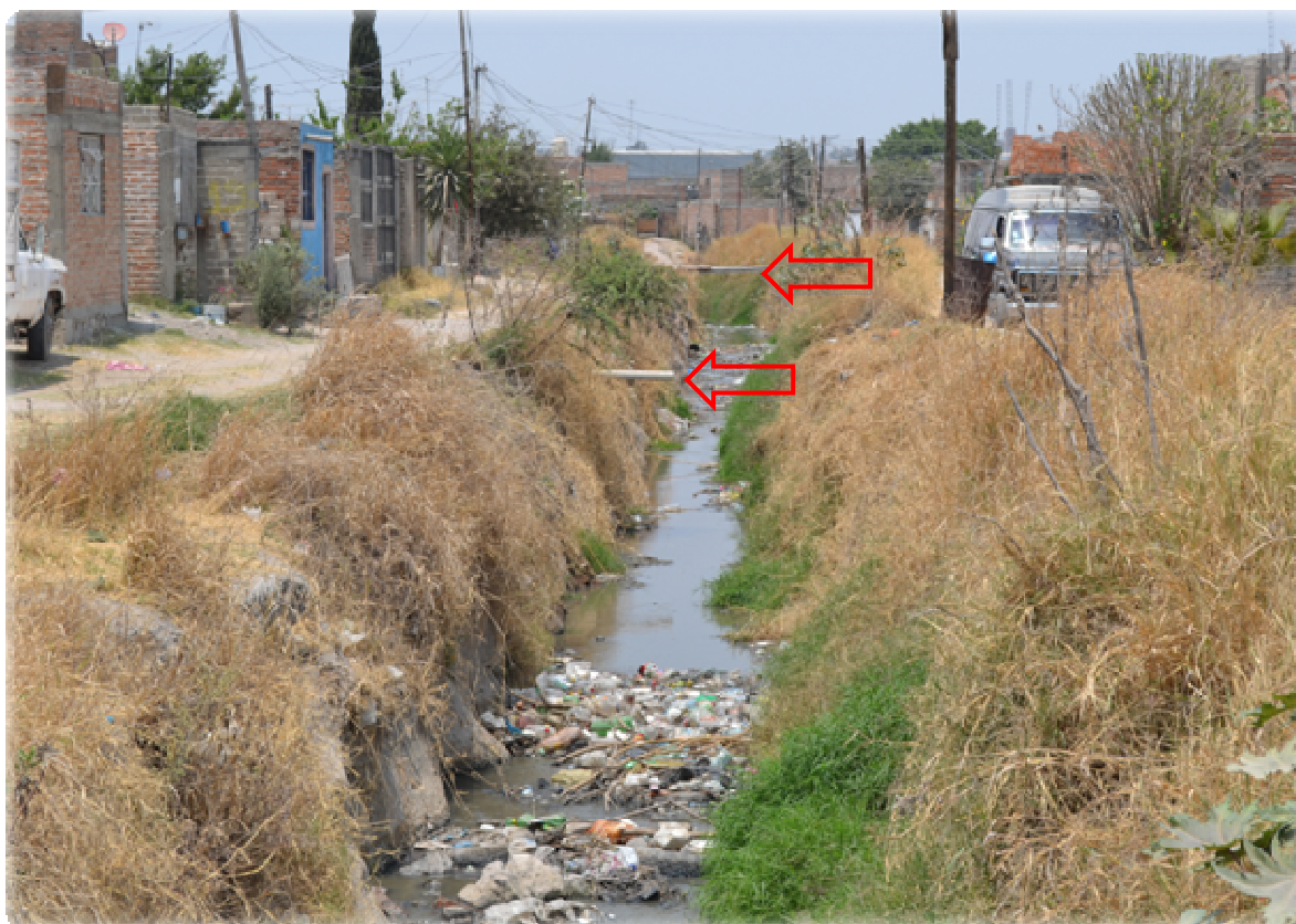
Imagen 2. Drenaje de la colonia Minerales que va a parar a un canal que después se encauza al de Las Pintas
