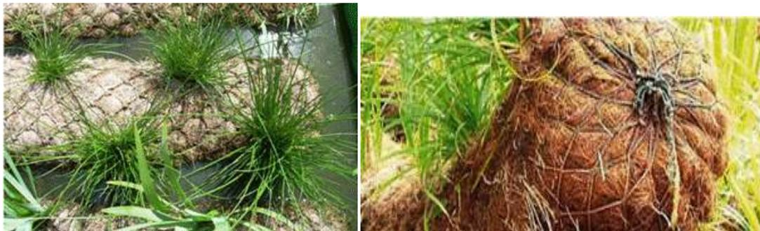
**Figura V.6 Colocación de biorrollos**
