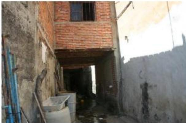
**Figura No.10** Arroyo parcialmente cubierto, termina abruptamente sobre la calle, generando problemas de inundación, debido a la insuficiencia de su canalización.
