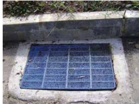
Figura 18. Protección de alcantarillado.
