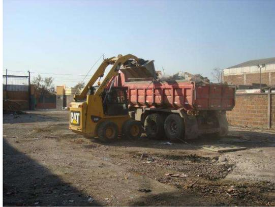
Figura 35. Depósito de material en camión recolector.
