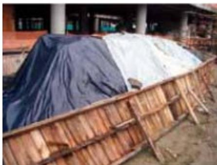
**Figura 4. Control de escorrentías y erosión del suelo.**
