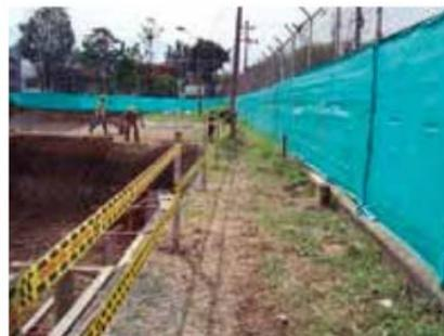
Figura 26. Barreras de contención perimetral.
