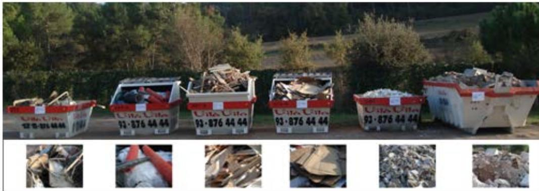
Figura 30. Ejemplo de separación de RCD.
