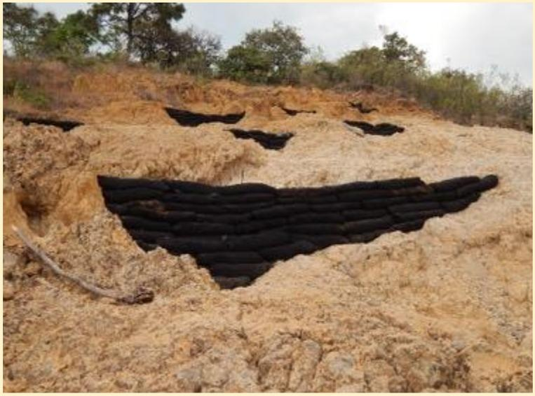
Obras de conservación de suelo con geocostales en la localidad de Atequizayán, municipio de Zapotlán el Grande, Jalisco.
