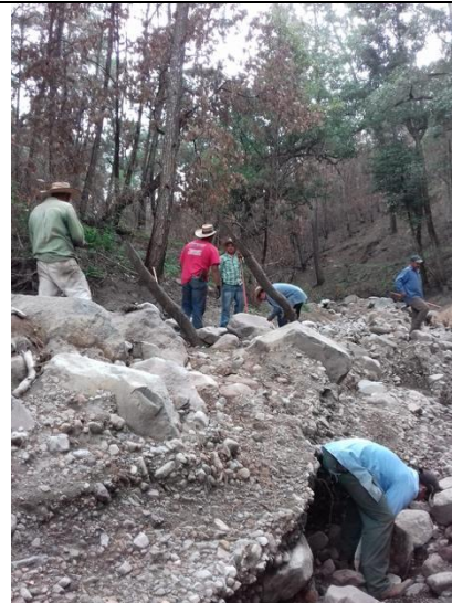
Actividades de la Brigada Regional de Manejo del Fuego Regional (Construcción de presas filtrantes y de piedra, Mpio. de San Gabriel)
