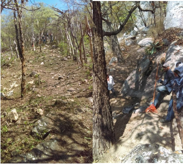
Rehabilitación de brecha cortafuego ejido Mezquites
