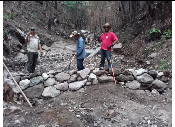
Actividades de la Brigada Regional de Manejo del Fuego Regional (Construcción de presas filtrantes y de piedra, Mpio. de San Gabriel)
