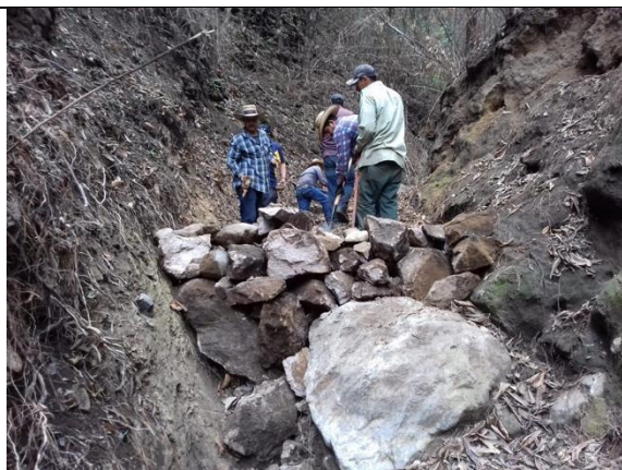
Actividades de la Brigada Regional de Manejo del Fuego Regional (Construcción de presas filtrantes y de piedra, Mpio. de San Gabriel)
